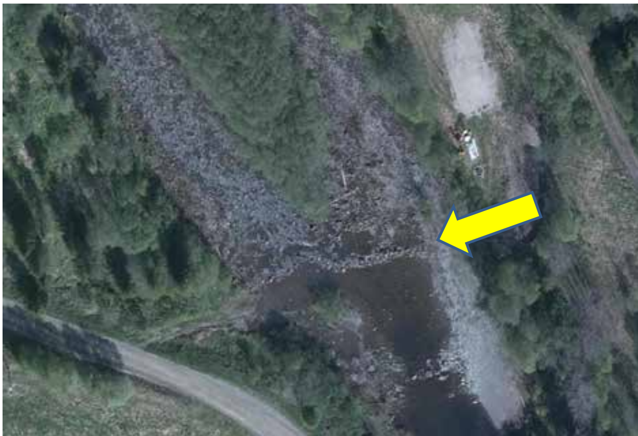
Figur 1. Flyfoto fra 2009 over avstengt/opptersklet sideløp i området Haugen, om lag 210 meter nedstrøms Åmotveiens brukryssning over Svorka. (Kartgrunnlag: http://kart.finn.no/ )
