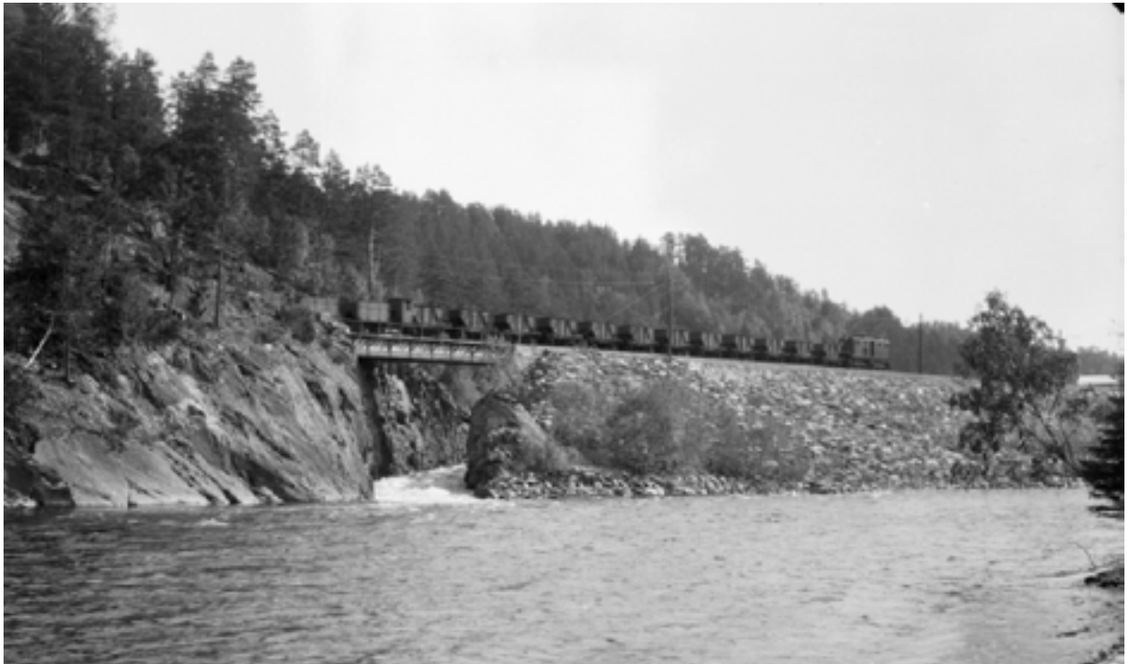
Figur 14. Svorkas munning til Orkla. Foto fra perioden 1925-1940. Fotografert av Karl August Berg/Orkla Industrimuseum. (Foto hentet fra http://digitaltmuseum.no )
