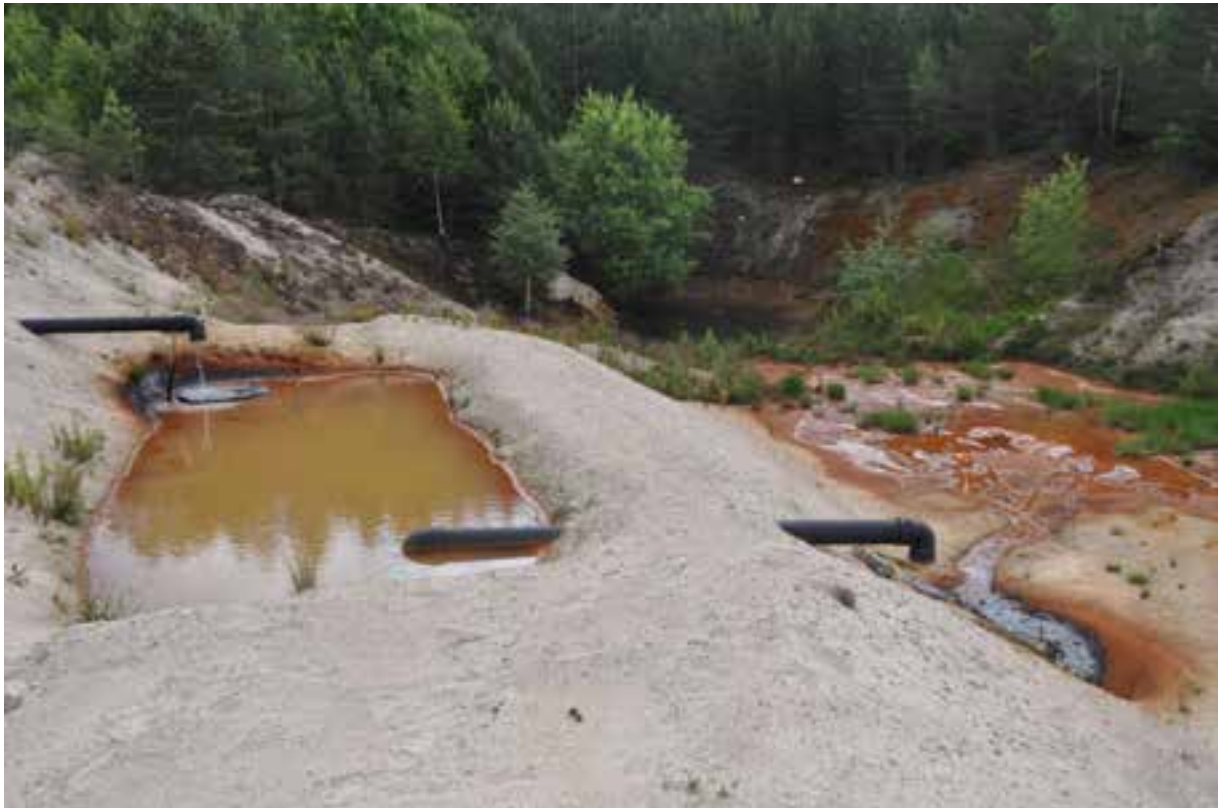
Figur 4. Dam for oksidasjon og utfelling av metaller, spesielt jern.
