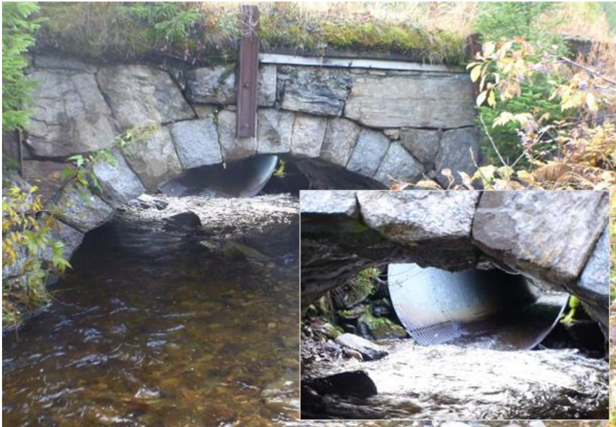
Figur 46. Oppøring foran kulvertinngangen kan etter hvert hindre eller stoppe oppstrøms fiskevandring. (Foto: Morten Andre Bergan)
