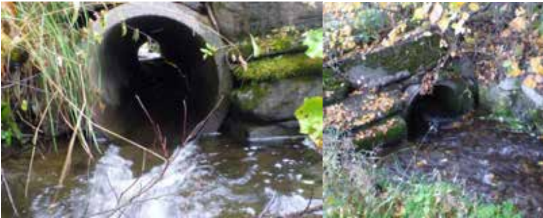
Figur 32. Krysning under Fv 964 i bekk ved Langlimoan (Foto: M. Bergan).
