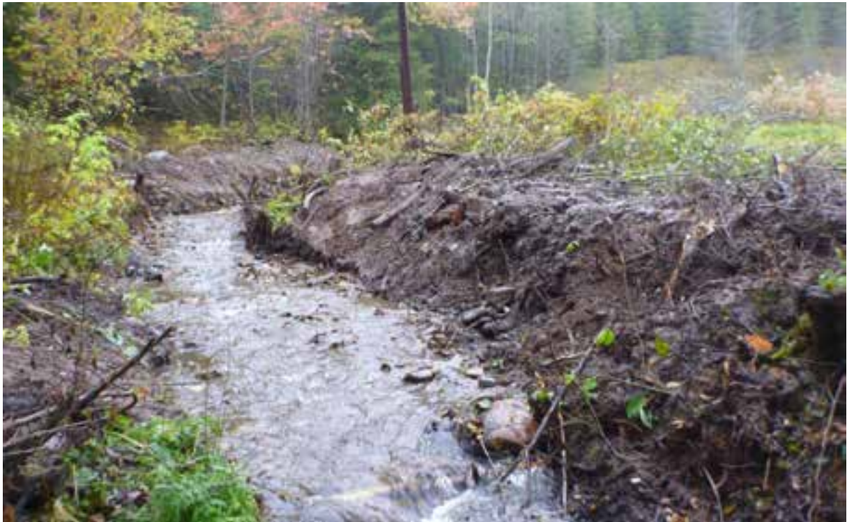
Figur 29. Kjelstadbekken like ovenfor Fv 964 (Foto: M. Bergan).
