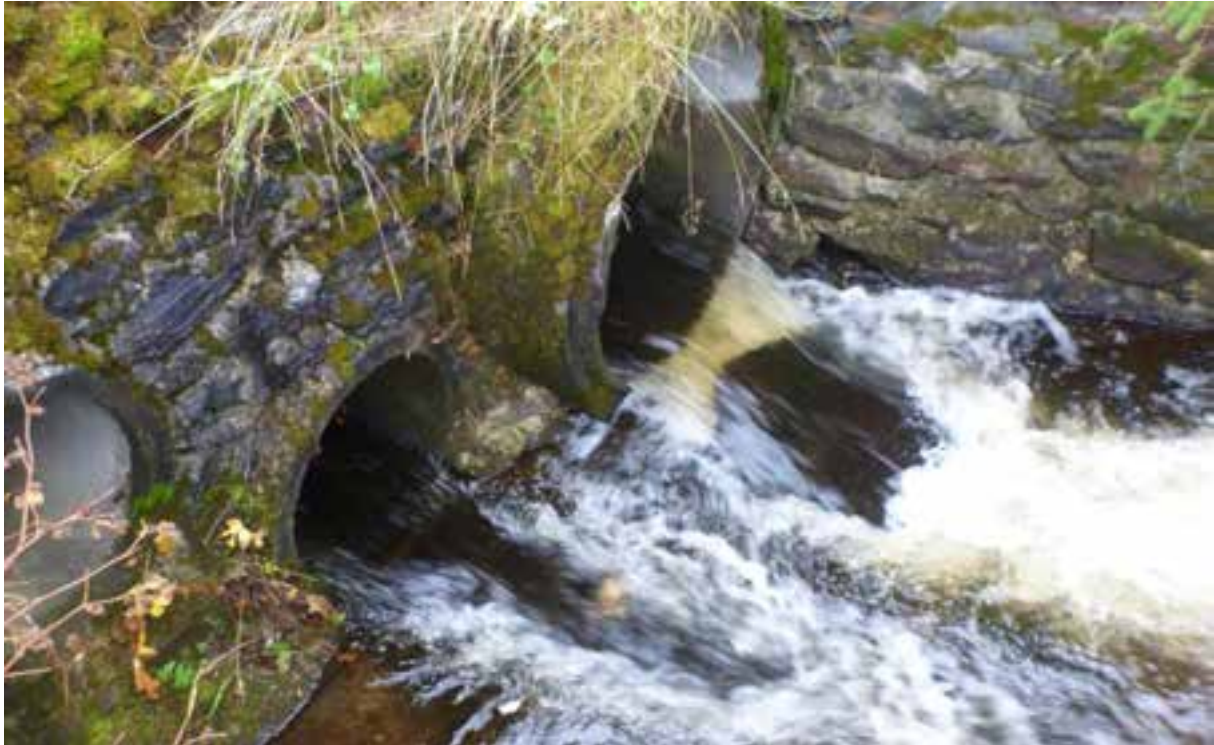
Figur 40. Kulvert under Fv 965 i Almåa (Foto: M. Bergan).
