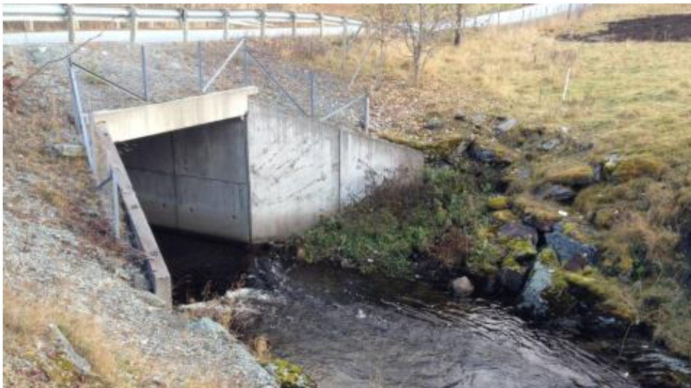
Figur 101. Krysning under Fv 963 er tilfredsstillende mht fiskevandring i Sneiselva/Vennelva. Foto: Hans Mack Berger.
