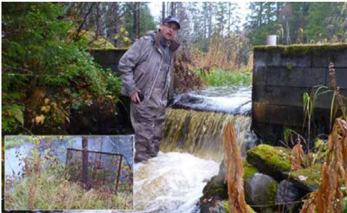
Figur 13. Menneskeskapt vandringsbarriere i Krokbecken før munning til Nea. Åpningen i steindemningen kan sperres med rist (innfelt foto) (Foto: Hans M. Berger).
