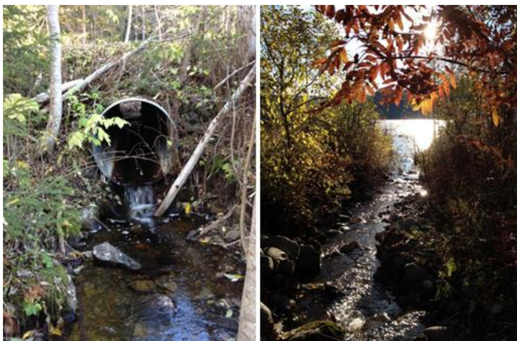
Figur 68. Kulvert under Fv 704 (t.v.) og Stamphusbekkens munning til Selbusjøen. (Foto: Hans Mack Berger).
