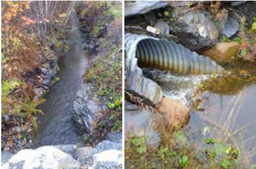
Figur 20. Stasjonsområde 6 b i midtre del av Låbekken (t.v.), og krysning under nyanlagt vei (t.h.) i nedre del av Låbekken (stasjonsområde 6a) (Foto: Morten Andre Bergan).
