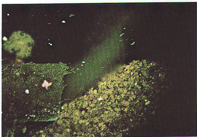
Fig. 82. Bildet viser liten vannføring og slamavsetning i en utløpsledning.
