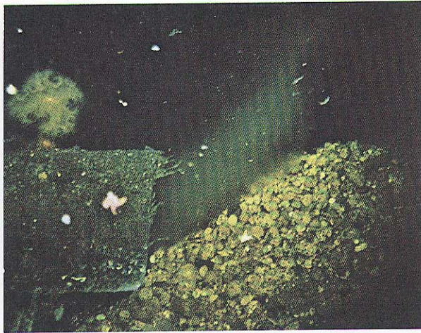
Fig. 82. Bildet viser liten vannføring og slamavsetning i en utløpsledning.
