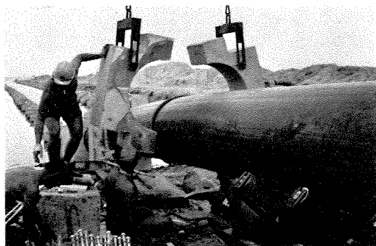
Fig. 40. Montering av betonglodd på PEH-ledning.
