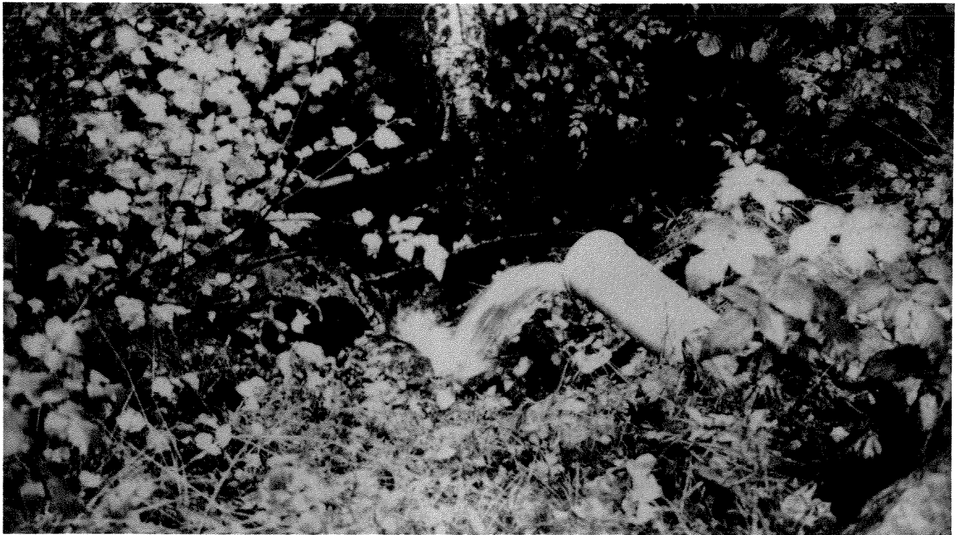
Avløp fra renseanlegget går rett ut i terrenget.
