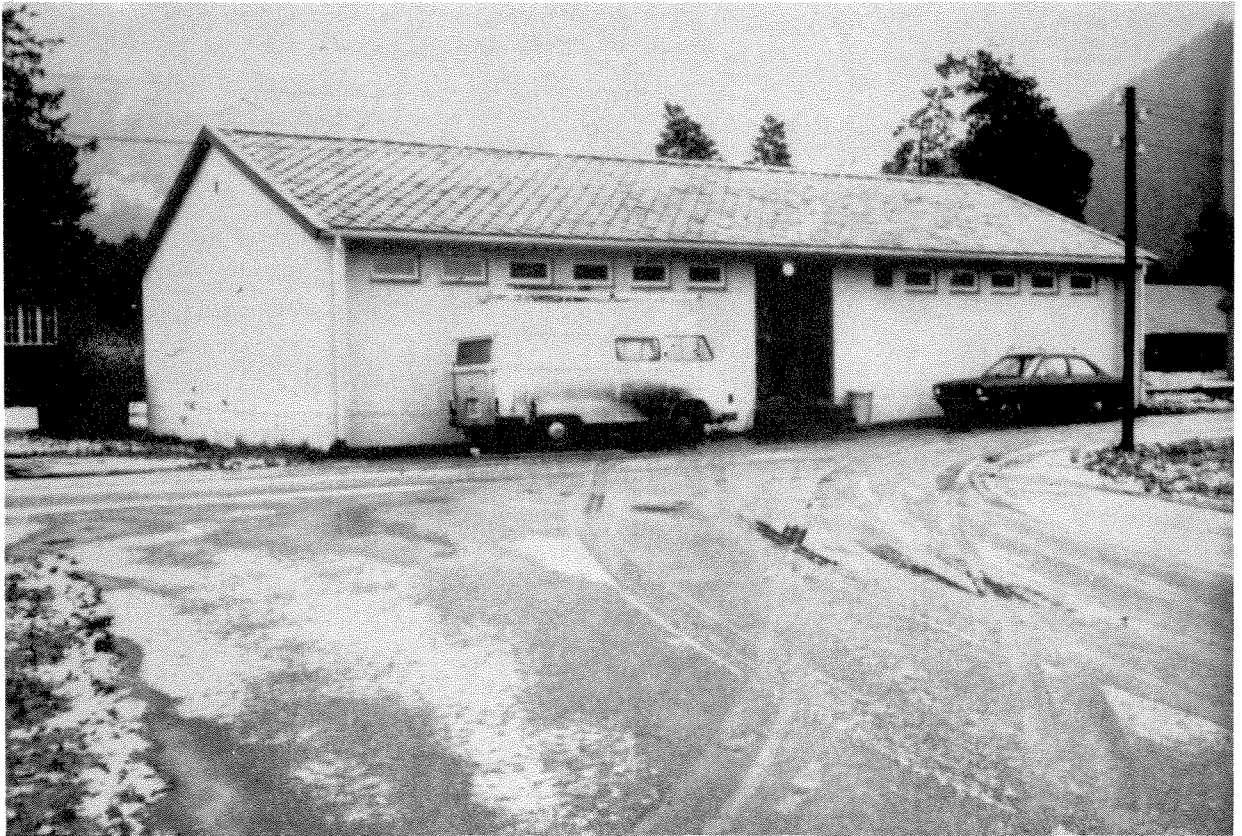
Bømoen renseanlegg (vaskerom og klosetter til venstre for inngangen, renseanlegget til høyre).
