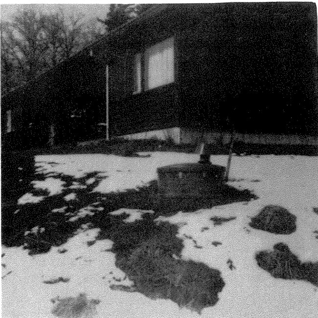
Søgne aldersboligers renseanlegg.
