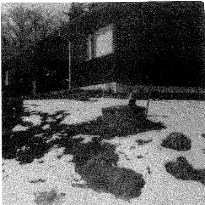
Søgne aldersboligers renseanlegg.
