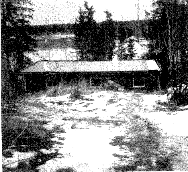
Våler batteris renseanlegg.
