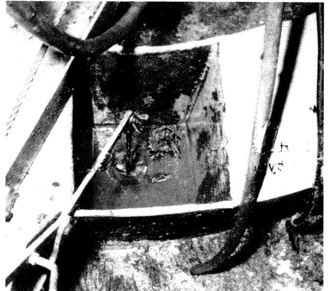
Utløpsrør med innstillbart overløp for konstant vannføring.
