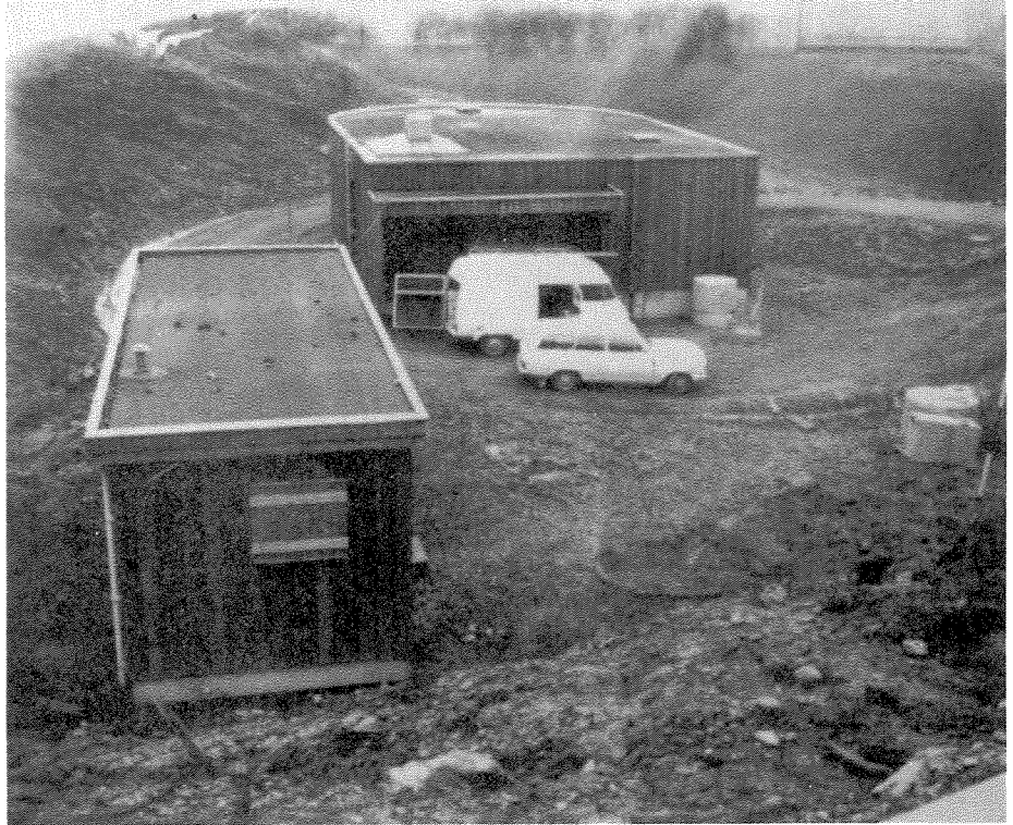
Søndre Aulie renseanlegg (betjeningsrom i huset i forgrunnen).
