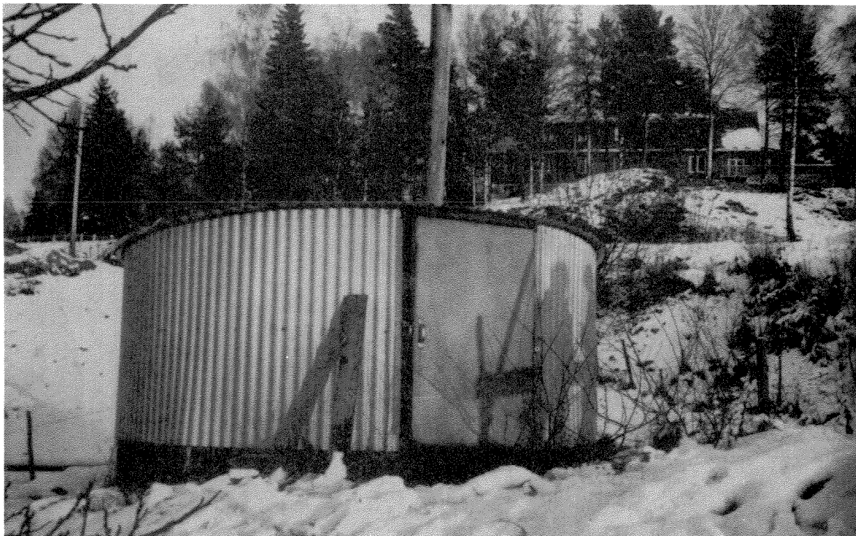
Enebakk sykestue's renseanlegg.
