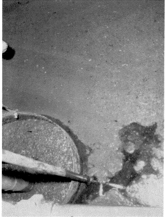
Flyteslam i sedimenteringstank. Flyteslamavdrag mangler.
