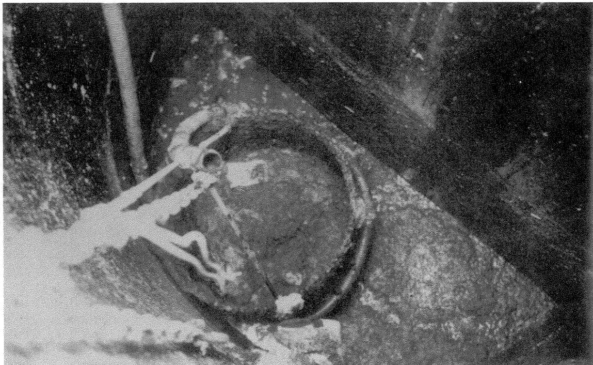
Ristkurven som henger nede i innløpskummen er altfor tung å heise opp for én person.
