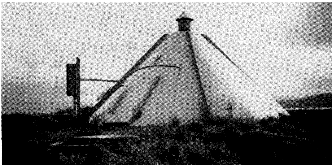
Evenes Lufthavn's renseanlegg.
