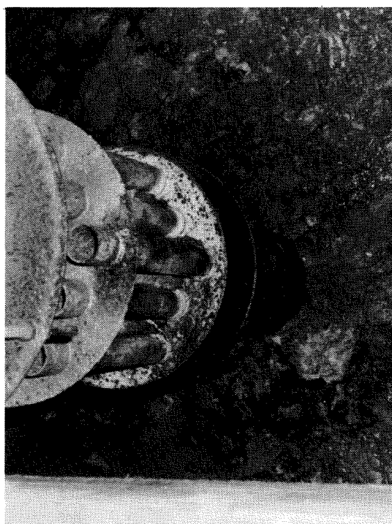
Denne type mammutluftere makte ikke å holde det aktive slam i omrøring slik at dette avsettes på bunn av luftetanken.
