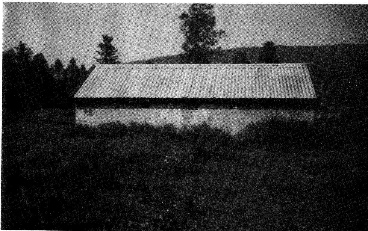
Vefsn landbruksskoles renseanlegg.
