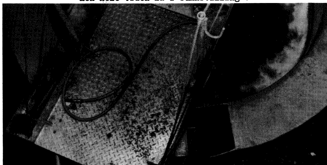
Bildet viser deler av anlegget innvendig. Merk flyteslammet i sedimenteringstanken utenfor klokken.
