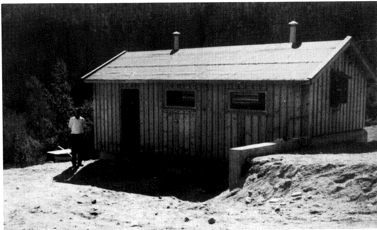
Brokke renseanlegg med infiltrasjons- arealet bakenfor.
