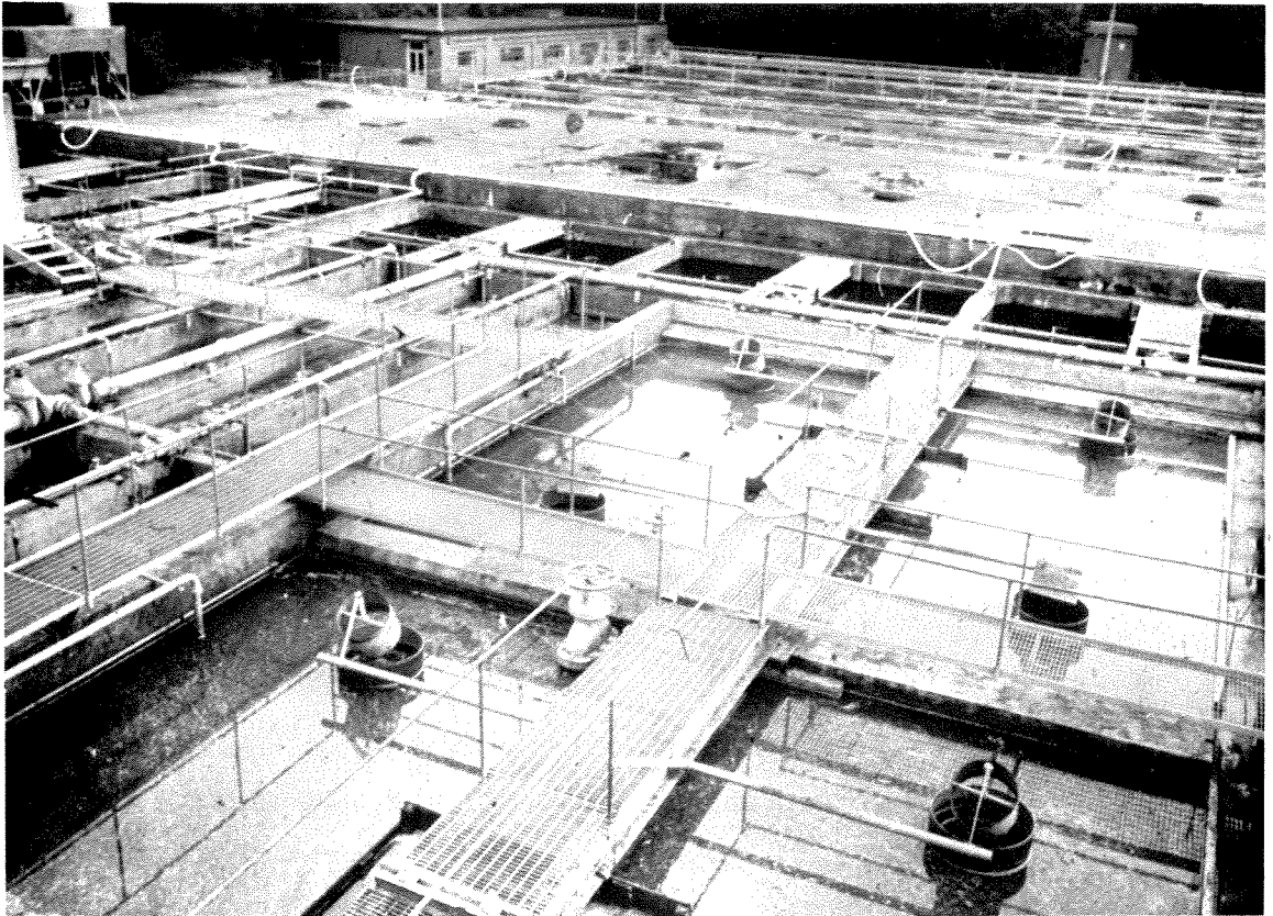
Fig. 2. Forsedimentering, eldre del og biologisk rensetrinn. I bakgrunnen kompressorhus med pumpestasjon for returslam.
