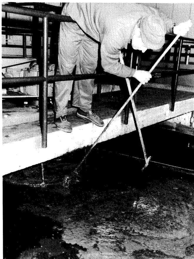
Det var meget tungvint å fjerne flyteslam fra innløpssylinderen i sedimenteringsbassenget.
