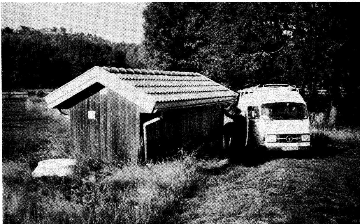
Hov alders- og sykehjem's renseanlegg Lagunen som utløpsvannet går ut i, ligger like bak anlegget.
