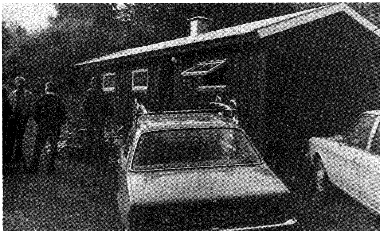
Namdalseid sentrums renseanlegg
