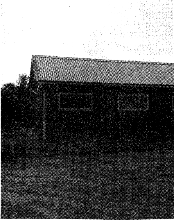
Høylandet sentrums renseanlegg
