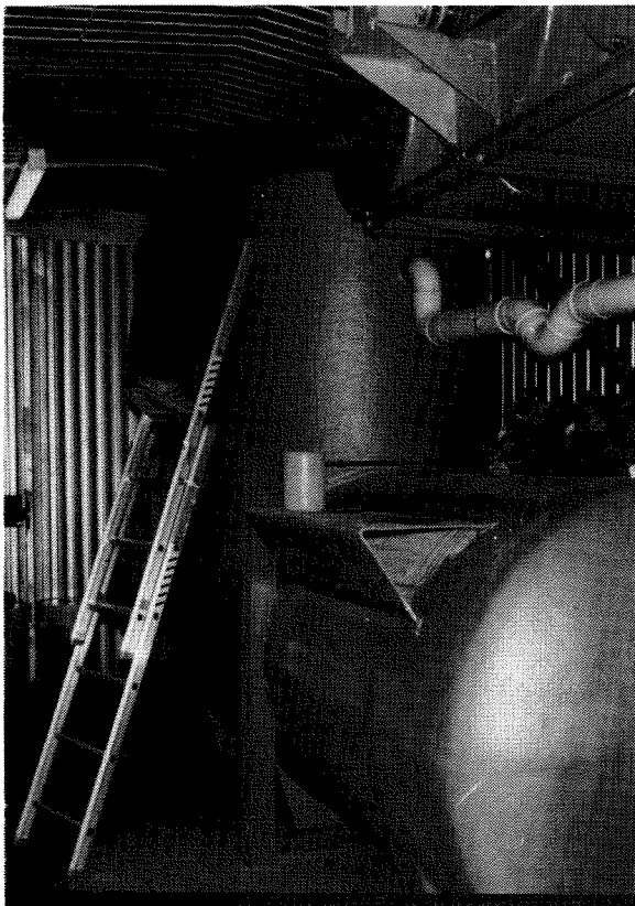
Interiør med slamtank. Bemerkt adkomst til lamellseparator
