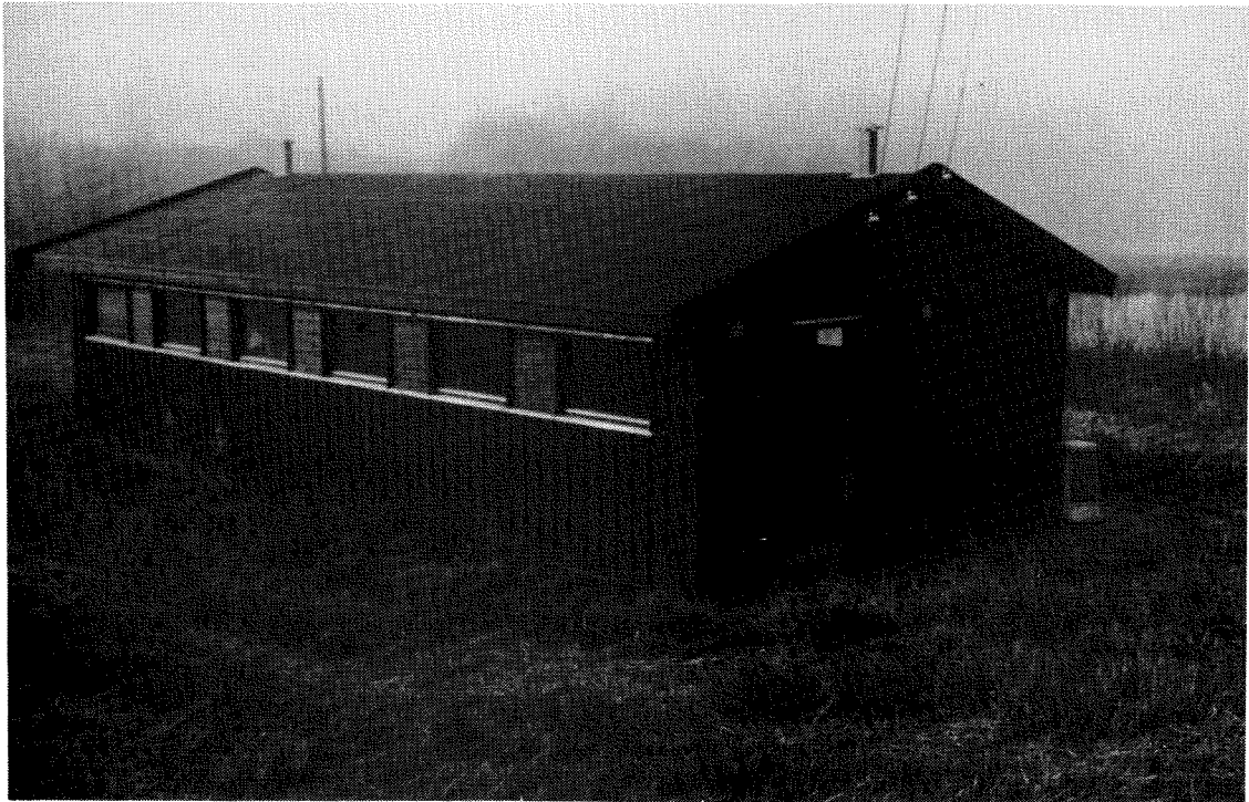
Prestfoss I renseanlegg
