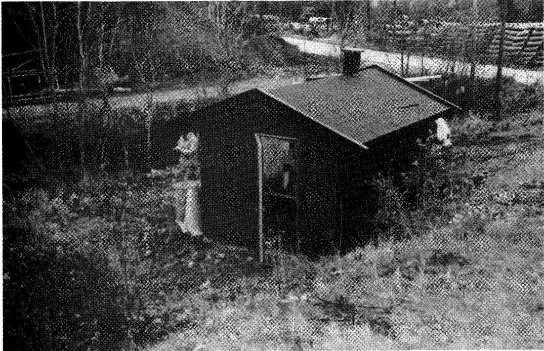
Haugfoss skoles renseanlegg.
