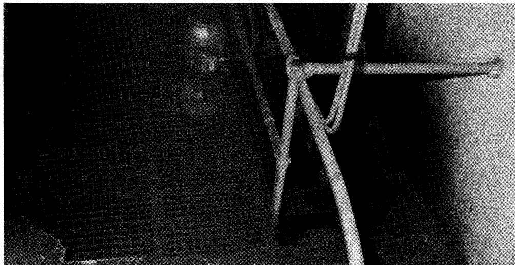
Interiør med slamsprut fra overflateluffer.
