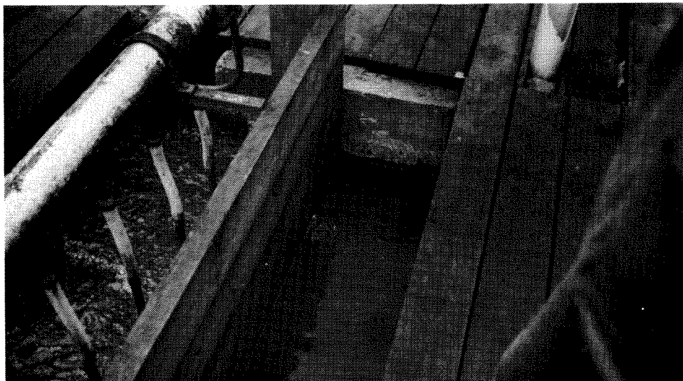
Skillevegg mellom luftetank og sedimenteringsbasseng. Luftbobler ved veggen skyldes kortslutning ved spalten. Aktivt slam kan ses helt oppe i overflaten.
