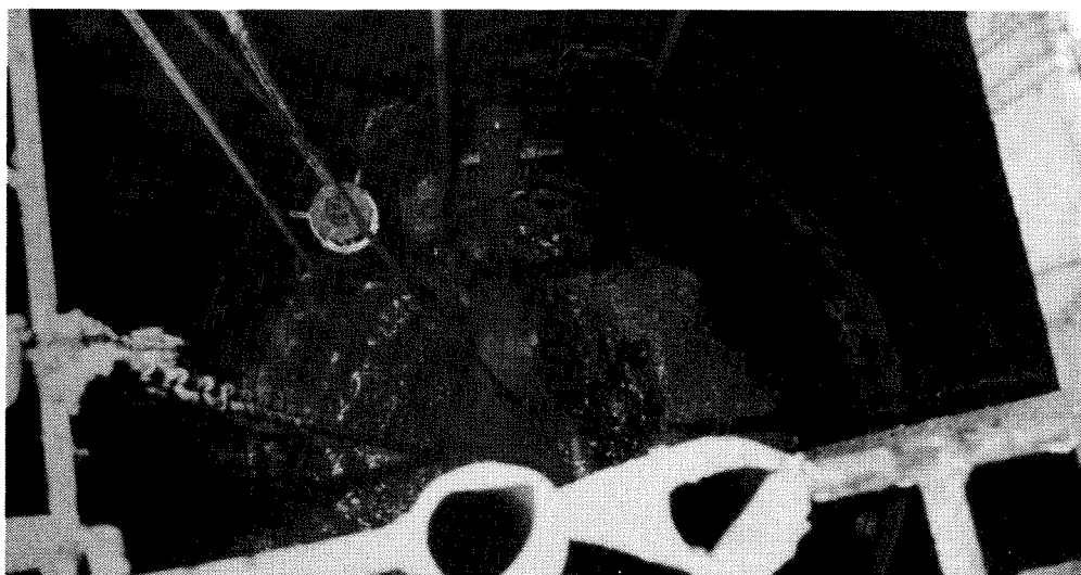
Pumpekum med grovrist. Ristkurven heises opp ved hjelp av vaier og vinsj. Dette er anmerket i teksten.
