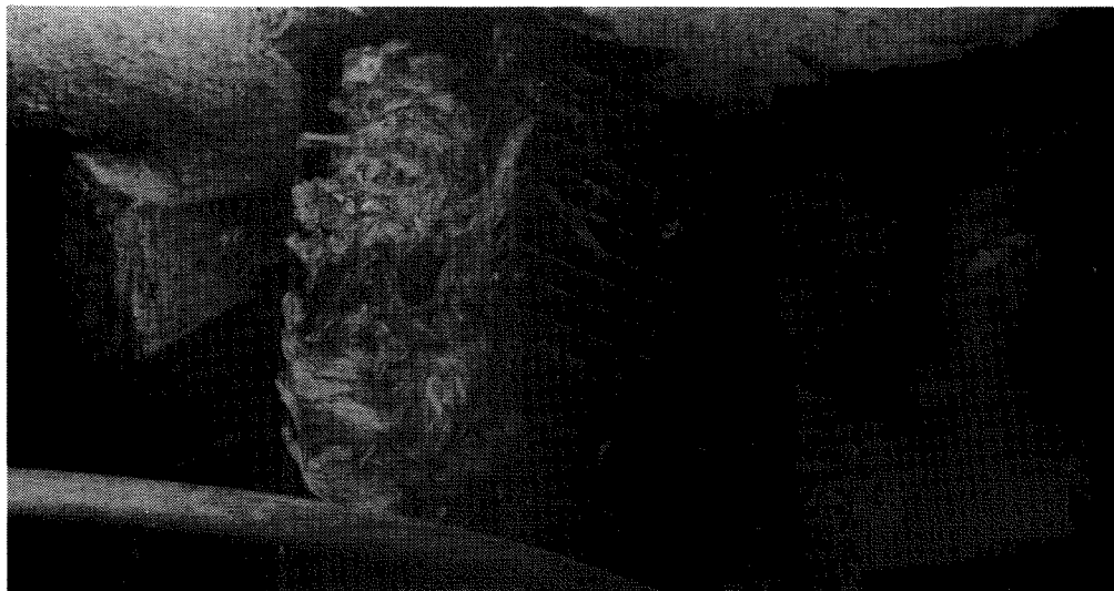
Rist. På grund av de betydelige ristgods- mengdene har man måttet fjerne noen staver for å hindre oppstuvning i ledningen.
