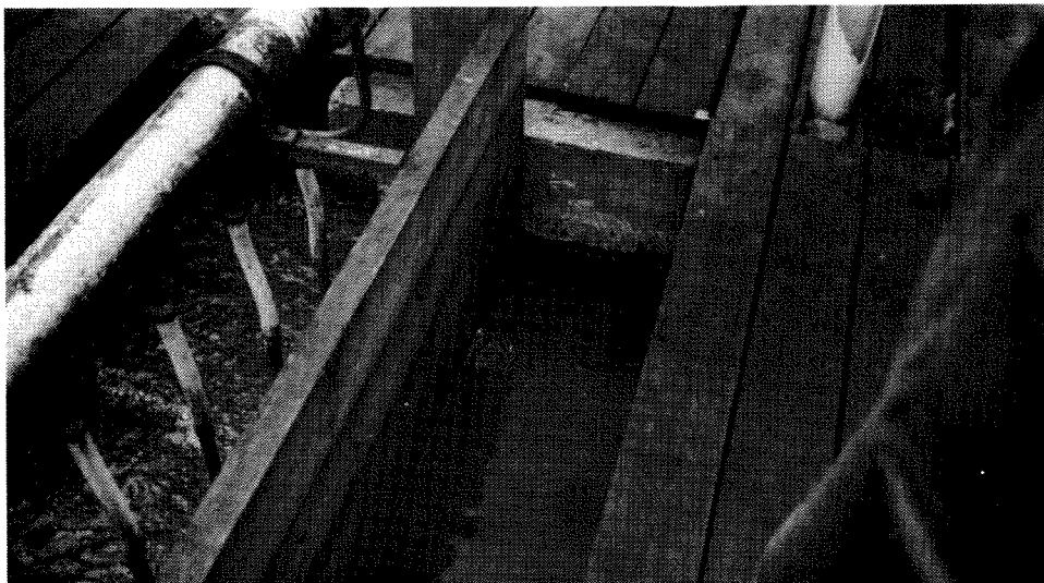
Skillevegg mellom luftetank og sedimenteringsbasseng. Luftbobler ved veggen skyldes kortslutning ved spalten. Aktivt slam kan ses helt oppe i overflaten.
