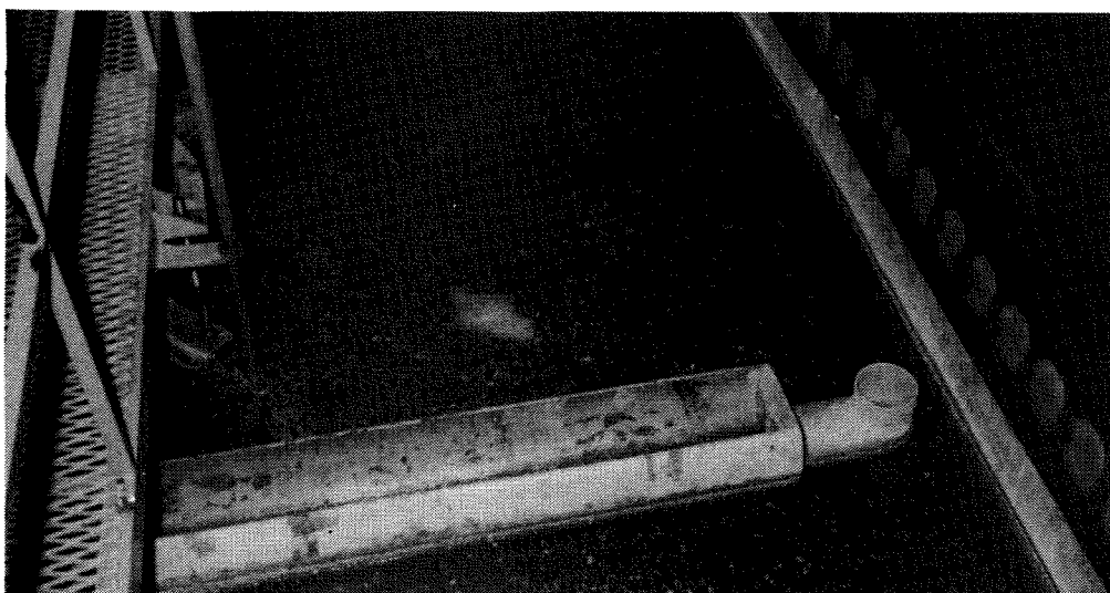
Sedimenteringsbasseng med flyteslamrenne. Flyteslammet må "måkes" mot rennen.
