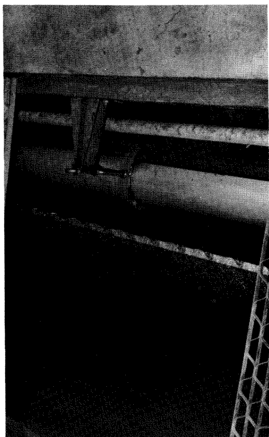
Overløpsrenne med flyteslamavdrag
