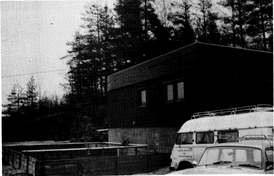
Bårud renseanlegg. I forgrunnen ses tørkesenger for utråtnet slam.
