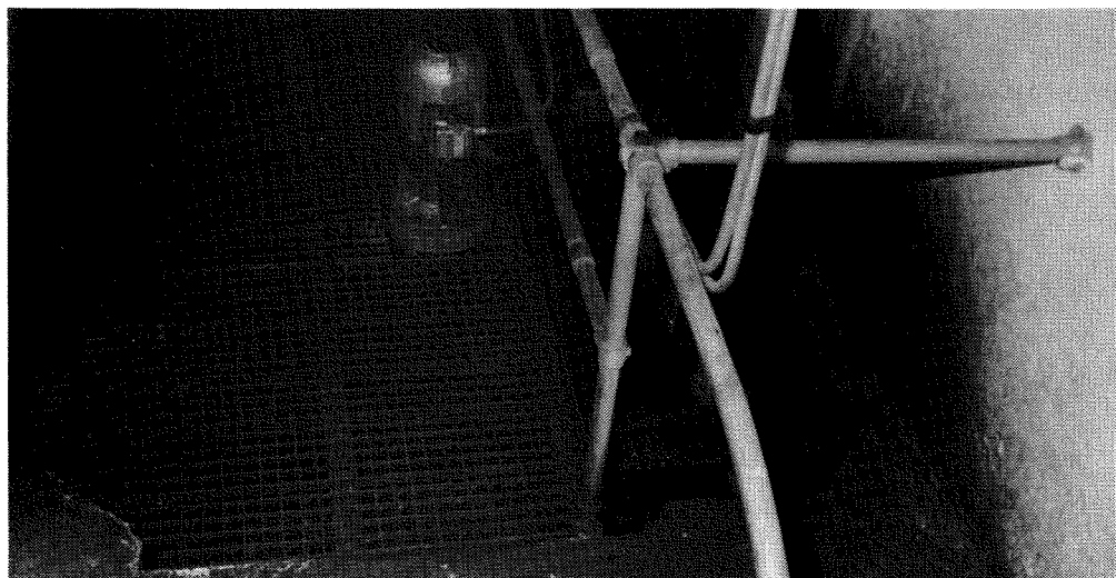
Interiør med slamsprut fra overflateluffer.
