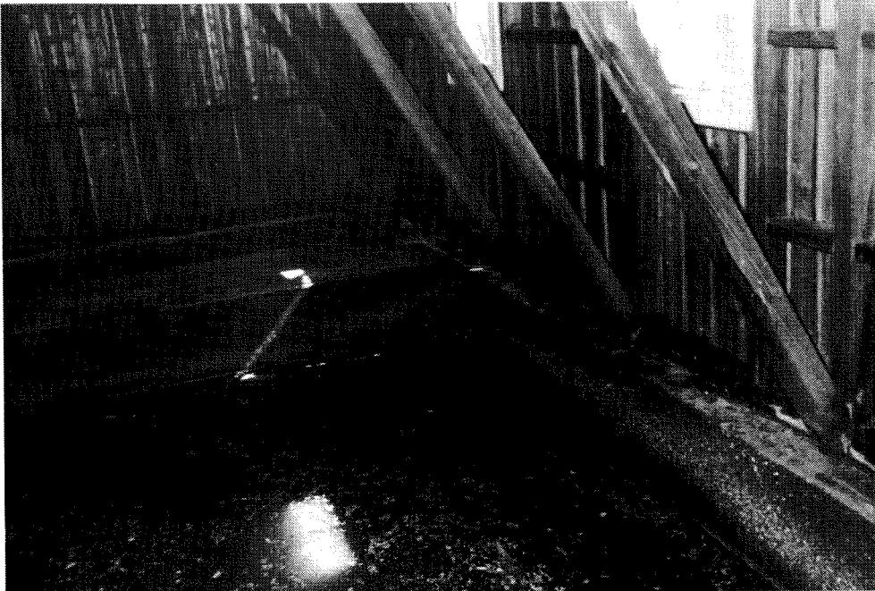
Interiør: Det er fuktskader på overbygget.
