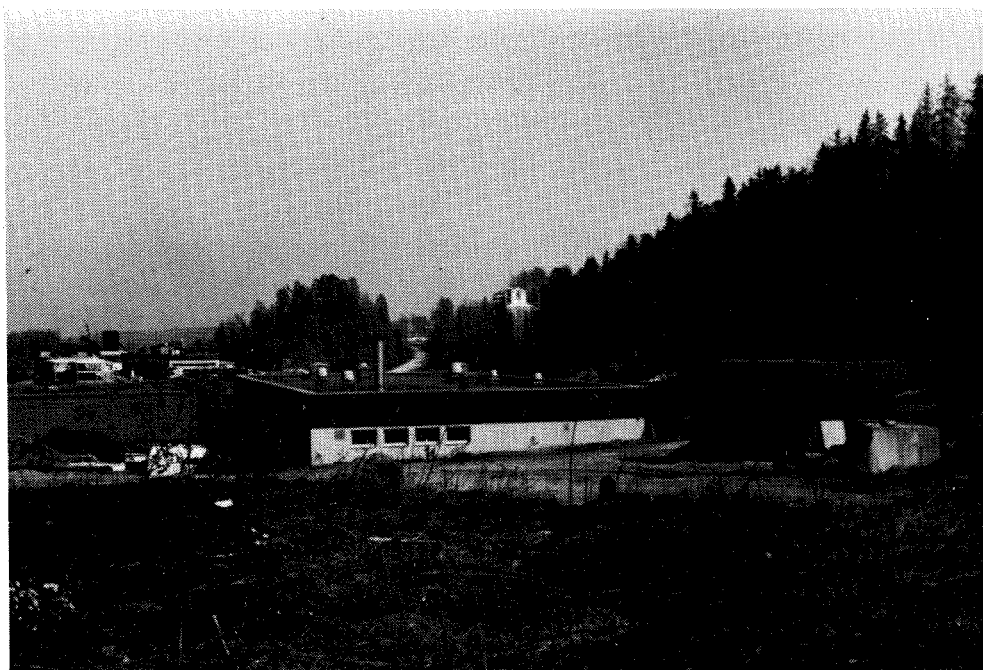
Slemmestad renseanlegg. En ser risthus for septik mottak til høyre.
