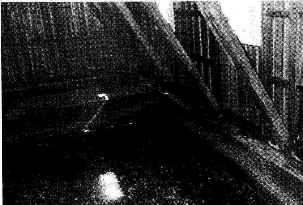
Interiør: Det er fuktskader på overbygget.
