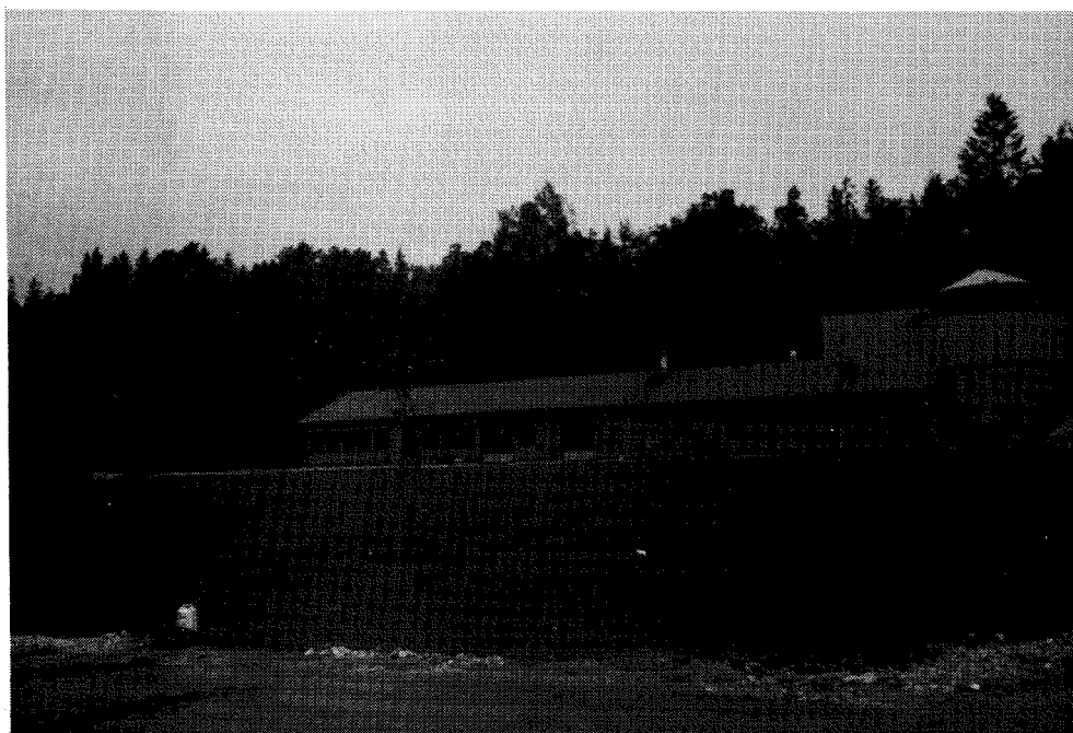
Søndre Follo Kloakkverk
