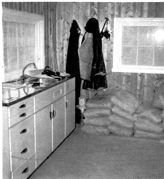
Fig. 17. Velferdsrom bør ikke benyttes til kjemikalielager.
