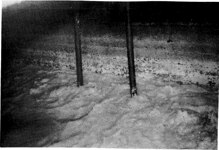
Figur 8b. Foto av luftet utjevningssasseng.
