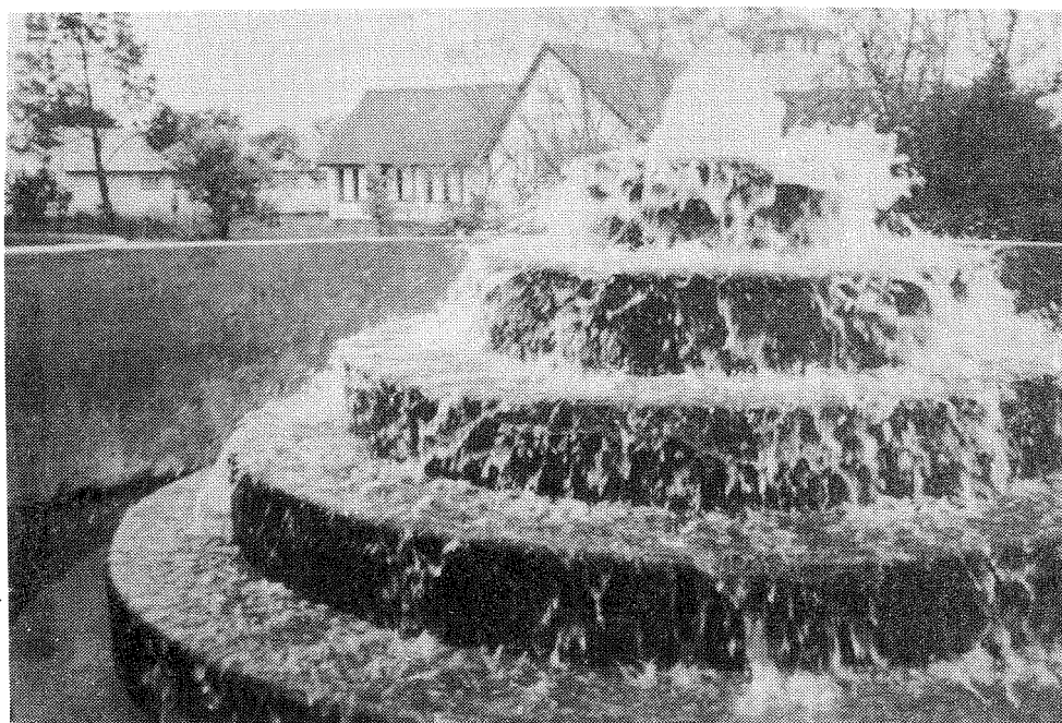
Figure 11. Tray-type aerator (Kalomo).
