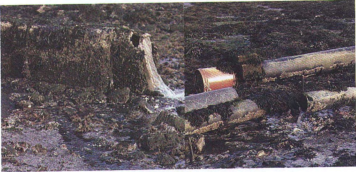
Fig. A3 Kloakkutslipp i fjæra. Venstre: Utslipp i nedre del av fjæra mellom stasjon 1 og 2. Høyre: Brudd på kloakkledning i fjæra nord for stasjon 8. Begge foto 28. sept. 1984.
