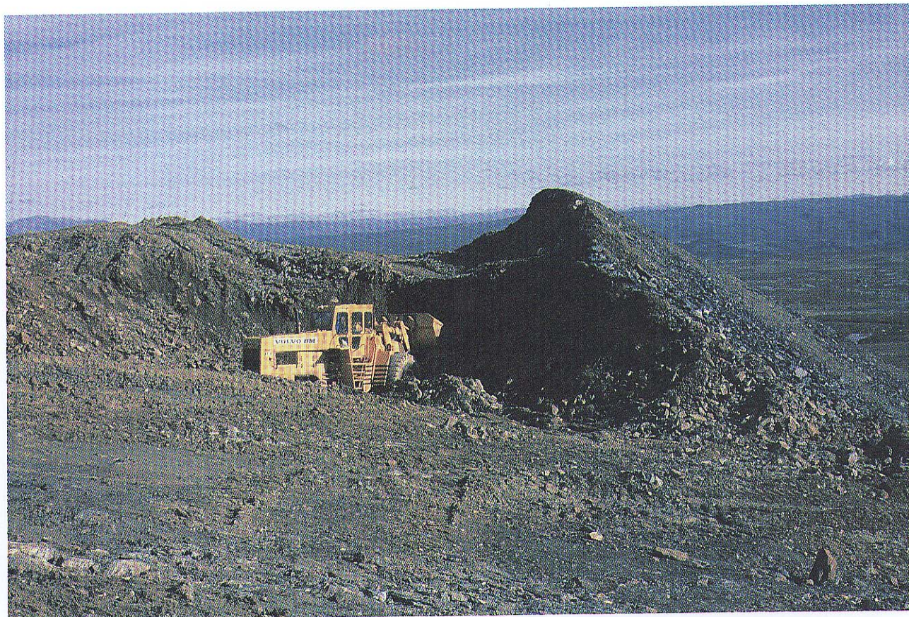
Bilde 3. Arrondering av velte 2. Store deler av nedre del av velten ble flyttet til kløften mellom haugene ( Bilde 2 ).
