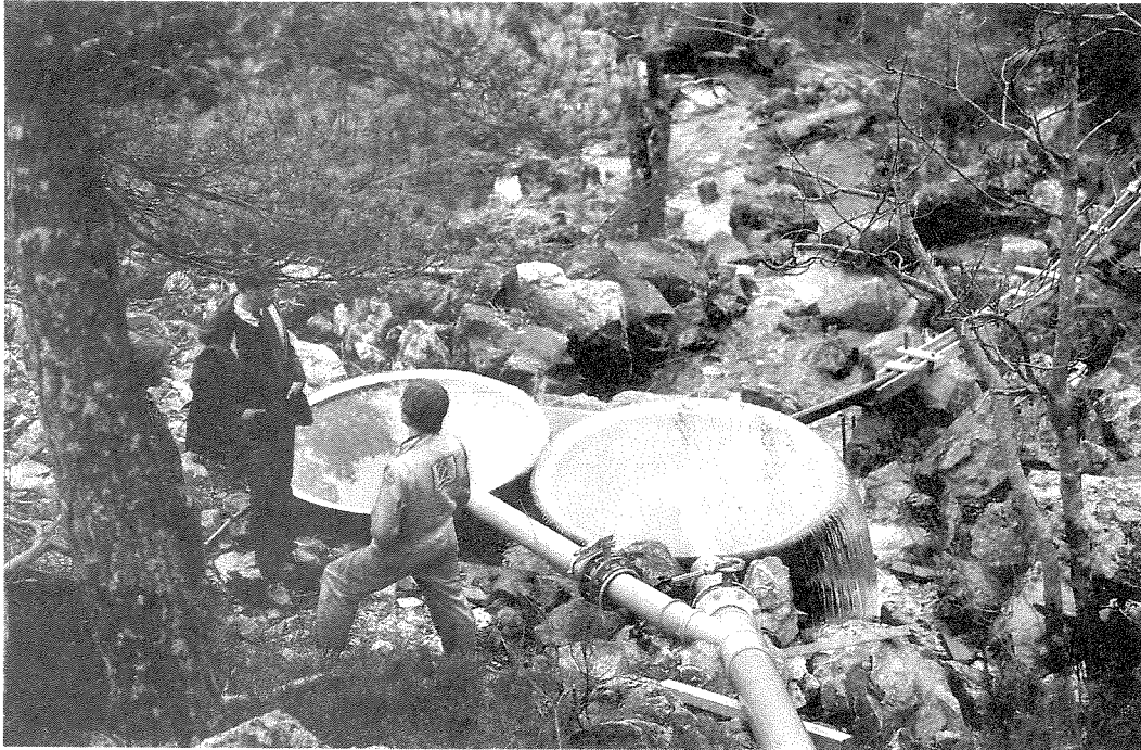
Fig. 4.1. Kalkbrønner for betring av vasskvalitet for setjefiskproduksjon, Stord.
