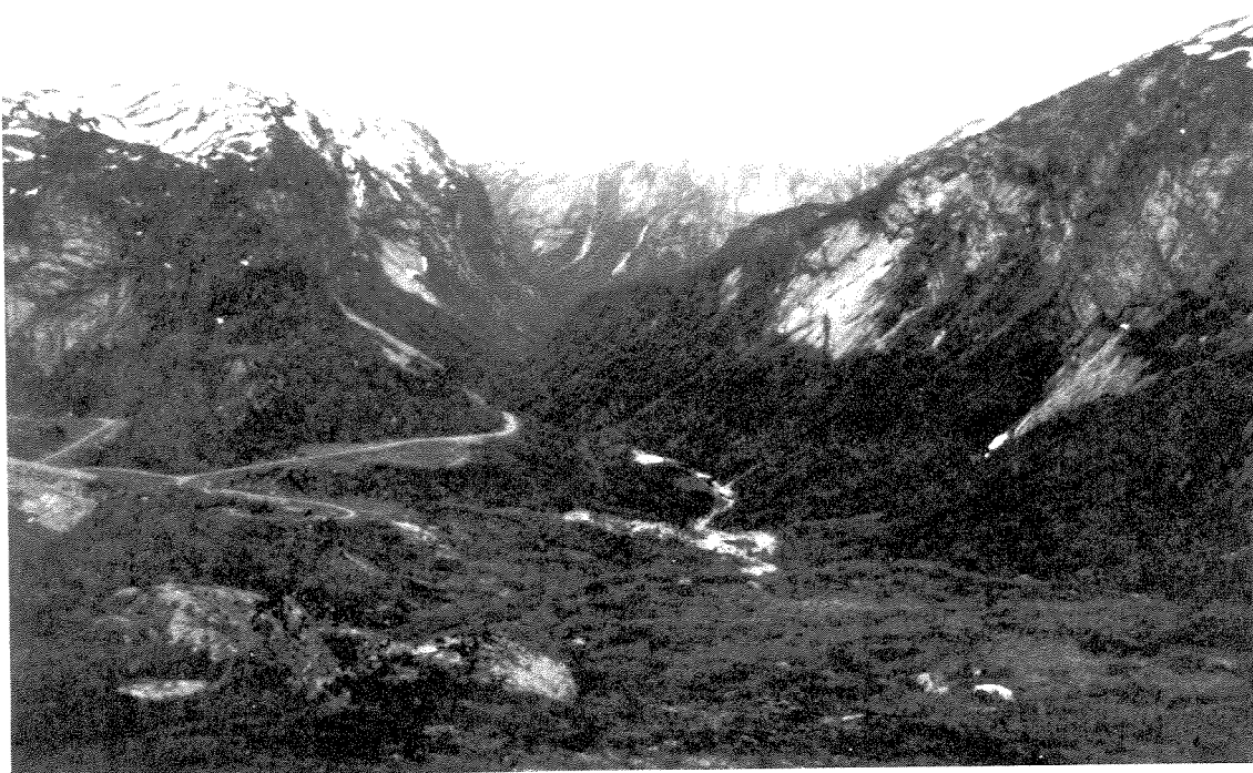
Utsikt mot Steinsland fra platået over Åsebotn. Til venstre på bildet sees anleggsveien fra Steinsland til Stølsdammen.
