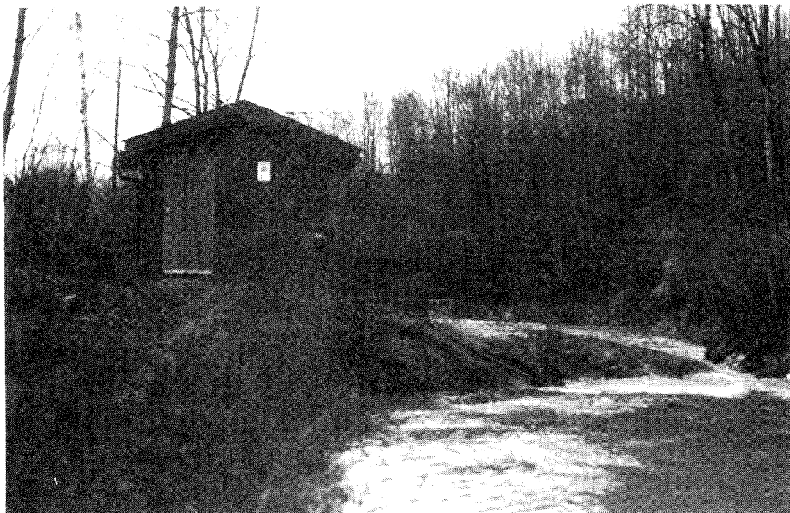
Fig. 5 Naturlig måleprofil i Åroselva. En lav betongterskel fra venstre elvebredd over fjellrabben mot tørrvørsrenna vil bedre følsomheten.
