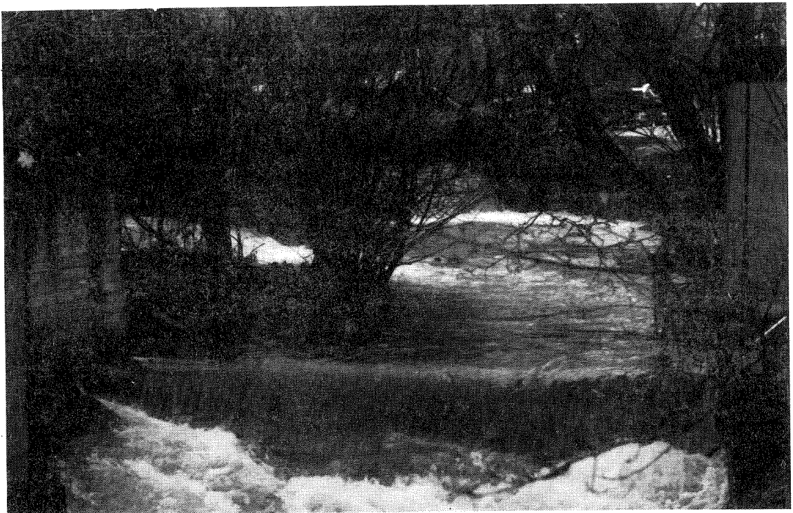
Fig.4 Målestasjon i Loelva med v-overløp støpt i betong. Deler av instrumenthus til høyre på bildet.
