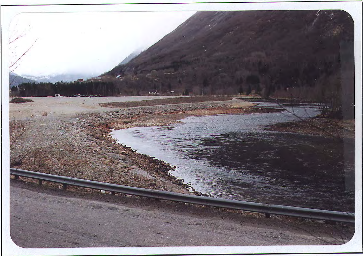
Figur 2. Nederste delen av avfallsplassen. Legg merke til okerutfelling og drenerør.
