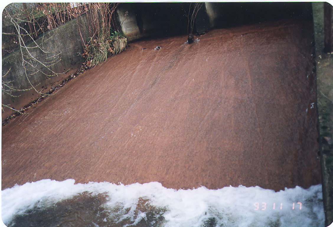
Foto 3.1. Solheim St. 1. Utløpet av overvannstunnelen i Solheimsvannet, 17.11.93
