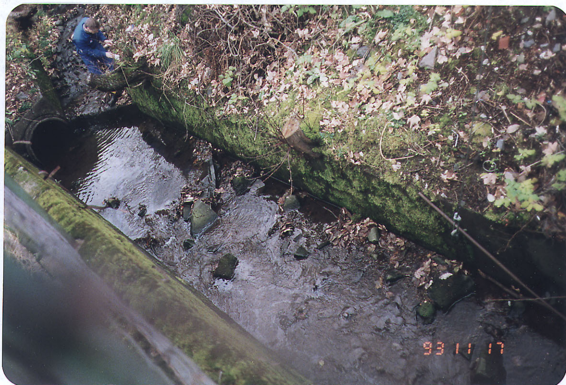
Foto 3.4. Overvannsledning til Tveitevann, St. 9 (betongrør) og St. 10 (bekken til høyre ovenfor samløp) 17.11.93.
