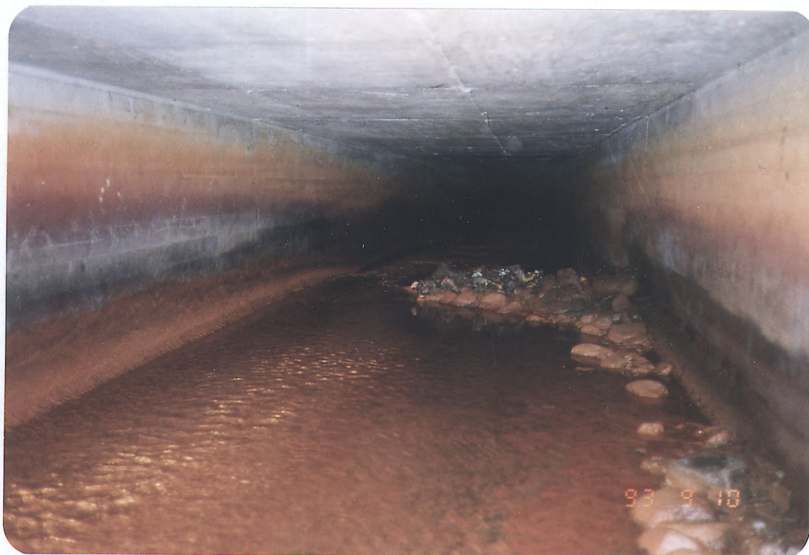
Foto 3.3. Solheim St. 4. Overvannstunnelen ved Haukelandshallen, 10.09.93.
