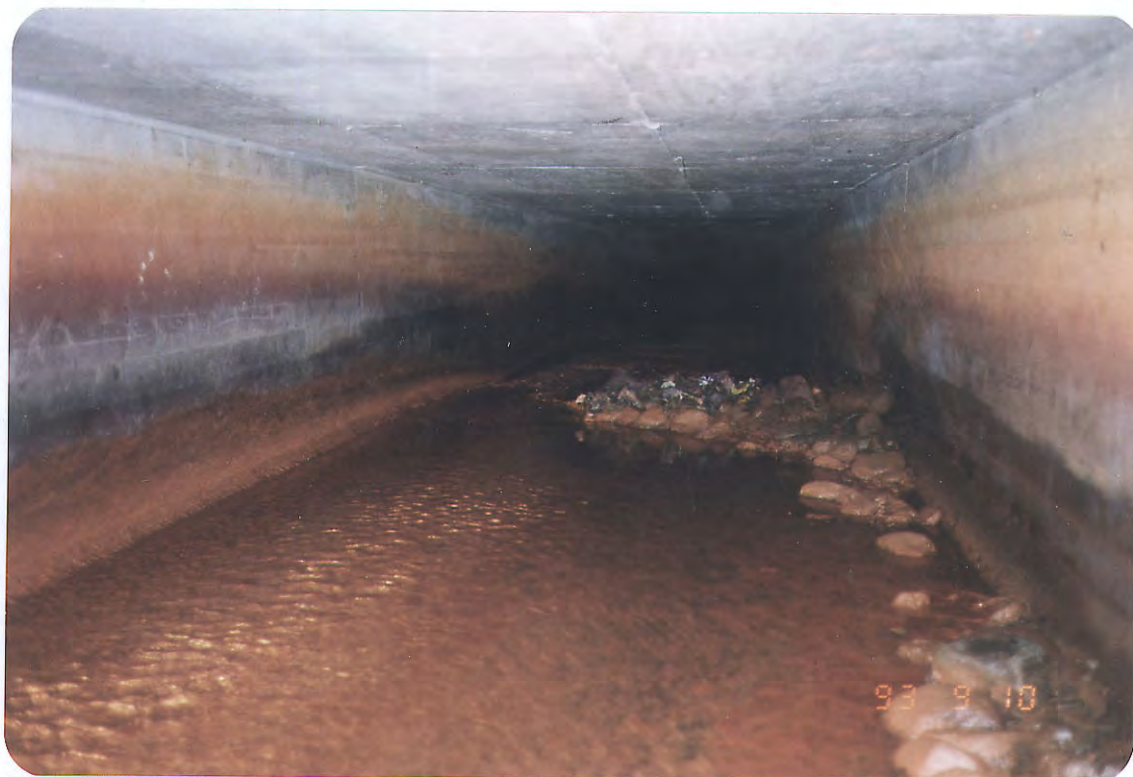
Foto 3.3. Solheim St. 4. Overvannstunnelen ved Haukelandshallen, 10.09.93.
