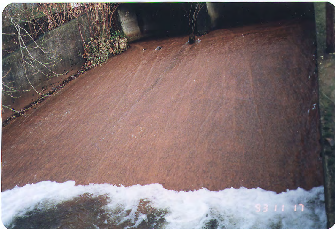
Foto 3.1. Solheim St. 1. Utløpet av overvannstunnelen i Solheimsvannet, 17.11.93
