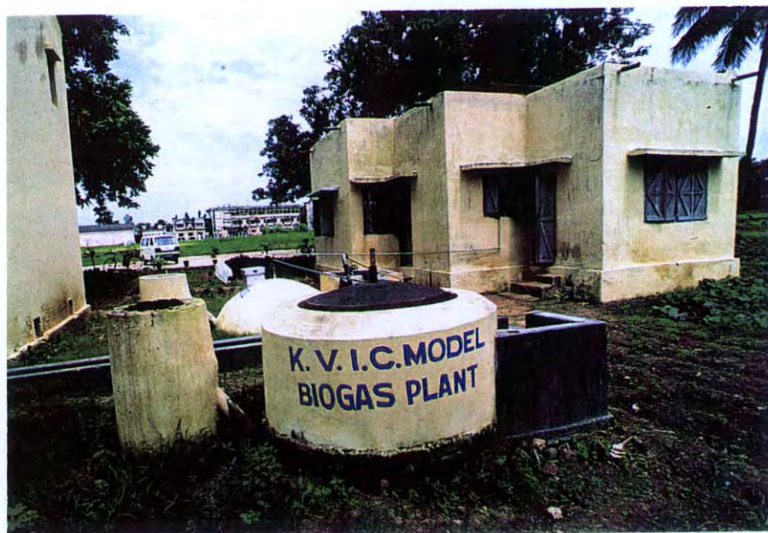
Figur 28 Demonstrasjonsanlegg for biogass på 1 ha. areal.
