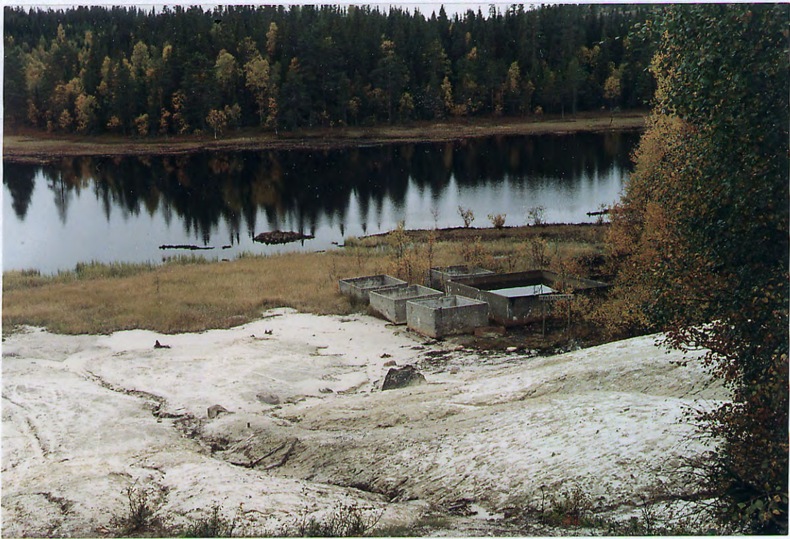
Figur 10. Eidsvoll Gullverk. Avgangsmasser ved Putten.
