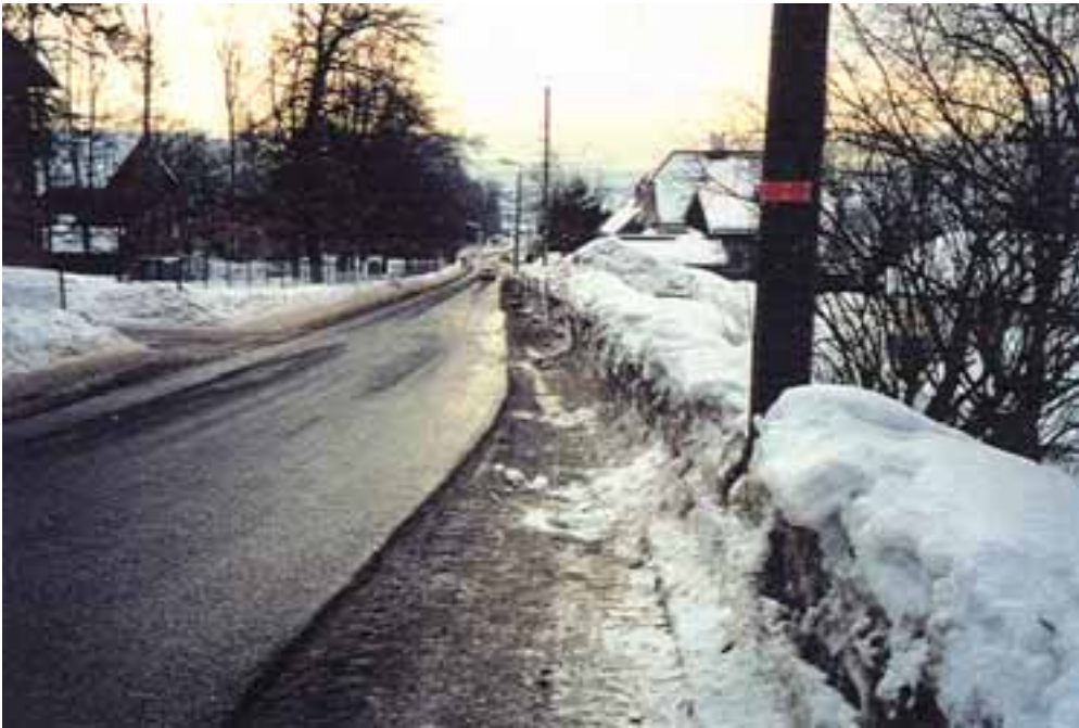
Figur 2. Grefsenkollveien etter fresing av brøytekanten.
