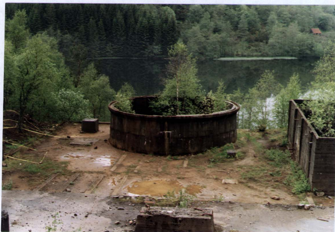
Figur 5. Fra oppedningsverket ved Litland
