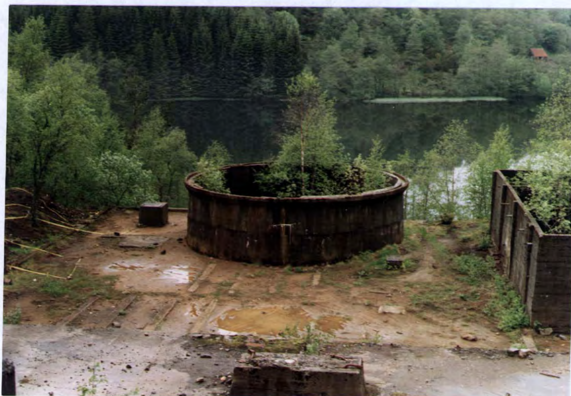
Figur 5. Fra oppedningsverket ved Litland
