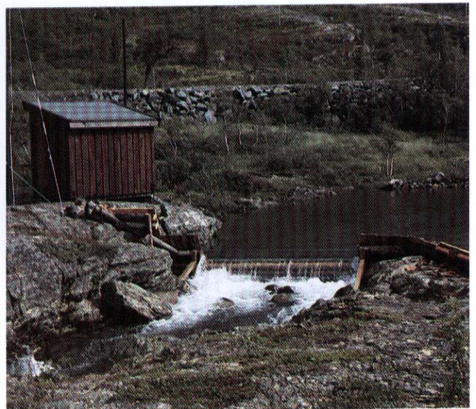
Målestasjon for vannkvalitet. Utløp Store Skorovatn.
