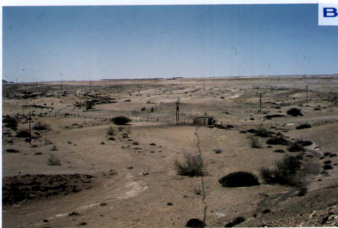
Figur 30. A. Landskapet rundt gruen med avgangstipper i bakgrunnen. B. En av kontrollstasjonene for grunnvannsovervåkning med tilbakepumping av grunnvann til prosessanlegget.
