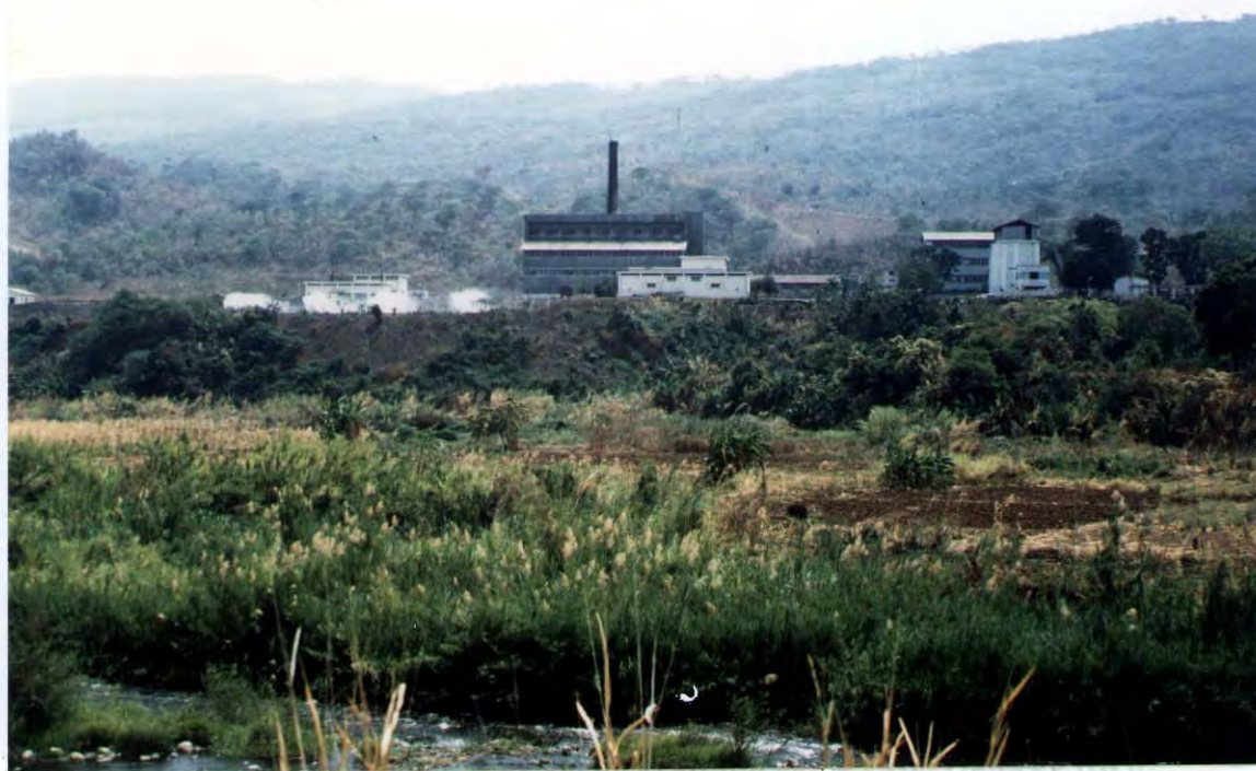
Figur 5. Kiwira Coal Mine. Foto av varmekraftanlegg og vaskerianlegg (til høyre). Kraftverket var ute av drift ved besøket.
