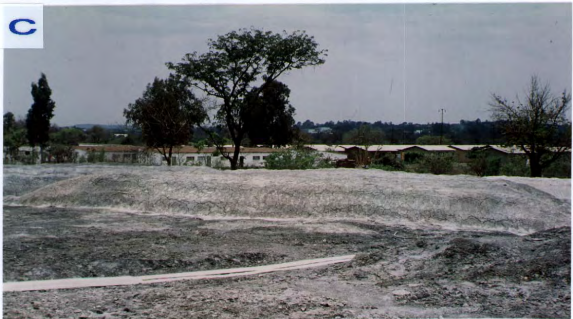
Figur. 22. The Roasting Plant, Kwekwe. A. Skorstein med renseanlegg for røkgasser, i forkant et tilfeldig lager av As- støv (ca. 80% ( \text{AsO}_3 )). B. As-støv foran renseanlegg. C. Deponi for As-støv, bebyggelsen ses i bakgrunnen.
