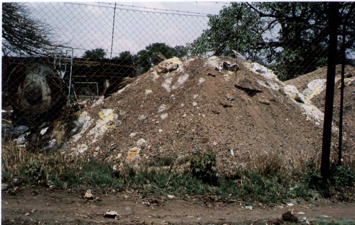
Figur 24. Gweru. Avfallstipp fra produksjon av kromholdige garverikjemikalier. På tippa fortsetter reaksjonen i rester av cromite og det dannes salter av 6 verdig krom (gule områder på bildet).
