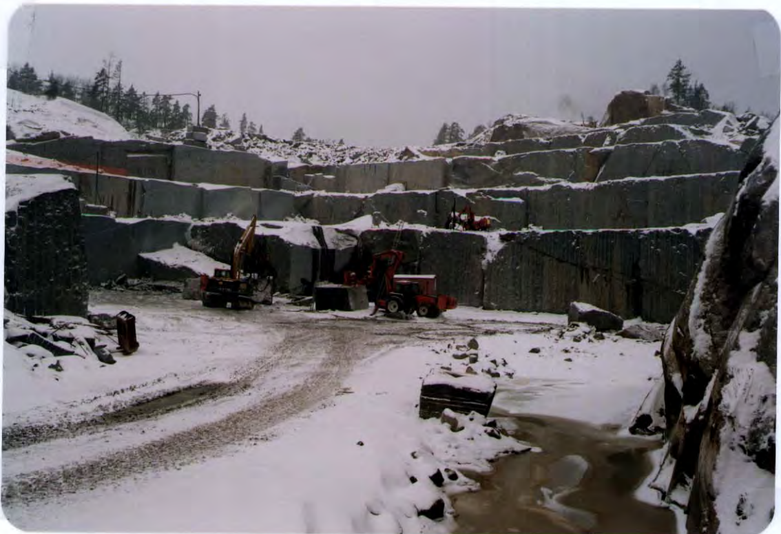
Fig.4 Avrenningen fra selve bruddområdet er gjerne svært turbid, se pumpesump i forkant av bilde. Der denne avrenningen ledes direkte til vassdrag, er dette en vel så stor forurensning som avrenning fra skrotsteindeponier.
