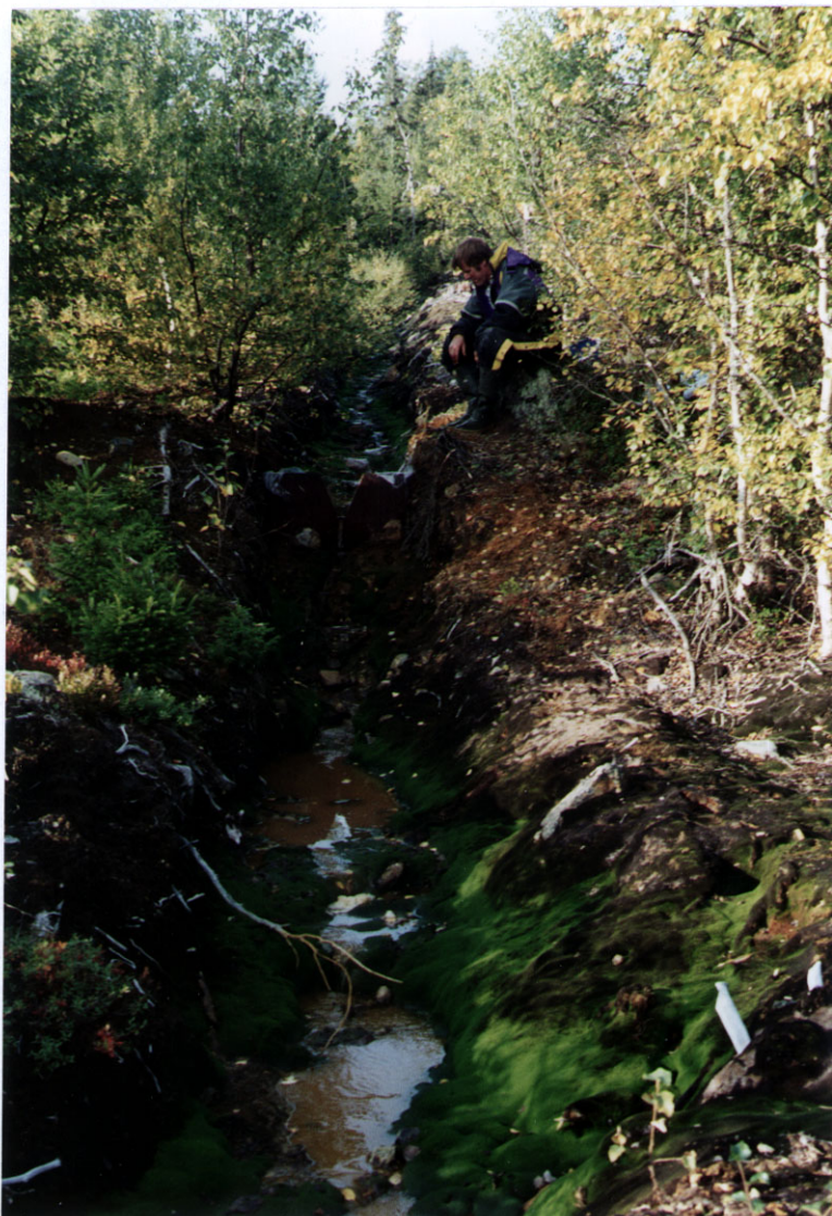
Figur 3. St.3 Drensgrøft nedenfor vei som krysser jernbanen ved Storvollen.
