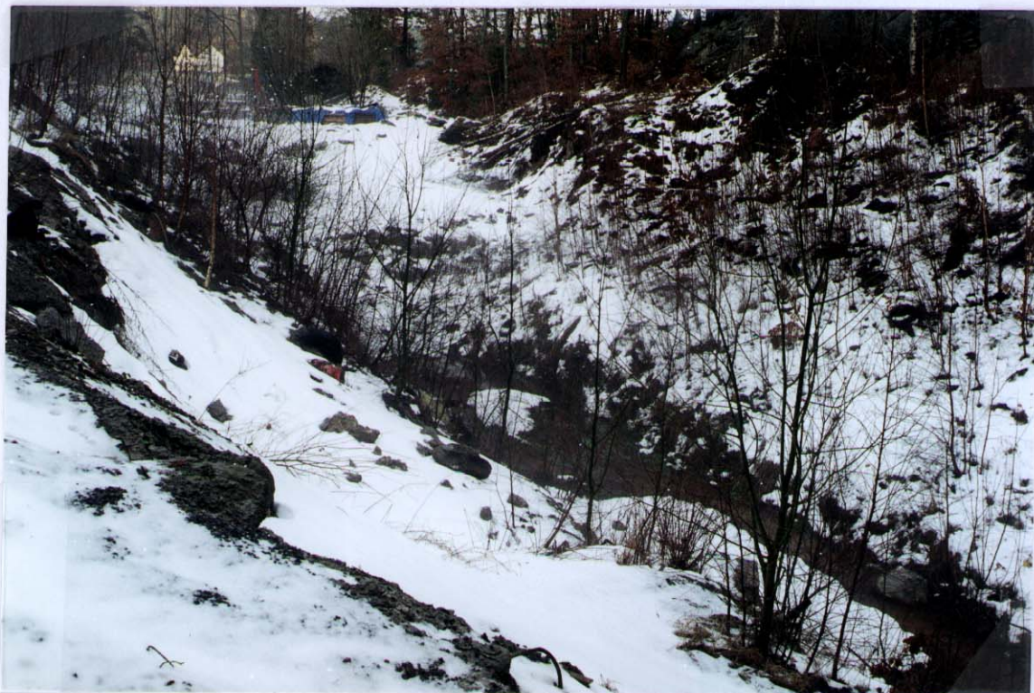
Figur 12. Morholt, Ågre fyllplass, Grimstad kommune. Nedre og eldre deponi.
