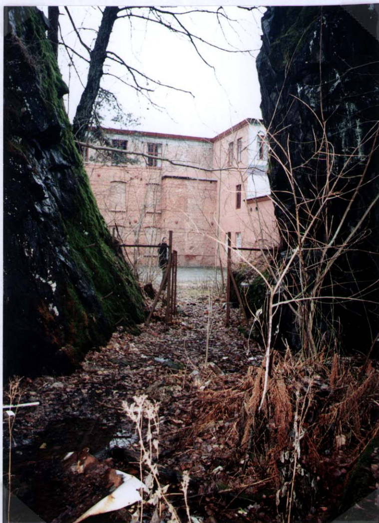
Figur 6. Langsæ gruver, Arendal kommune. Nedre adkomst sett fra gruva.
