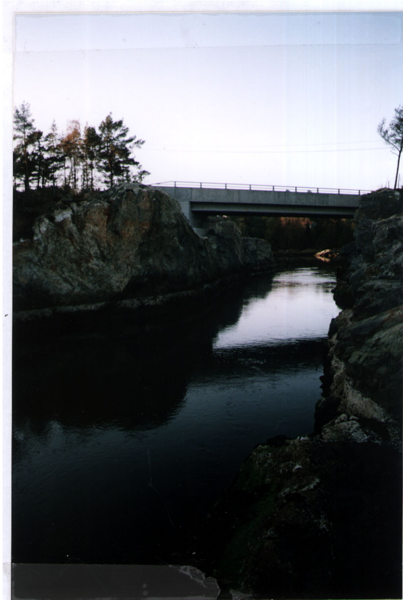
Figur 2. Bilde tatt fra Vestrepollen, oktober 1998, som viser den nye kanalen inn til Vågsbøpollen.
