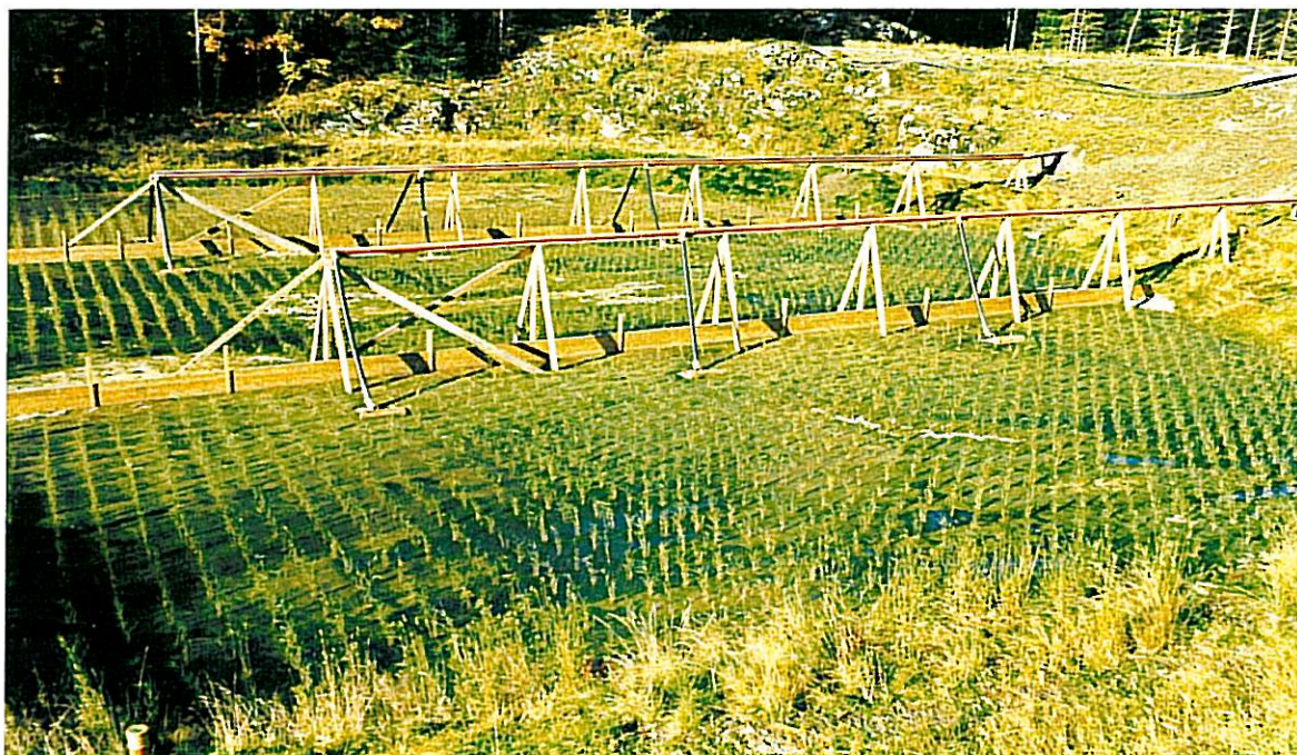
Figur 4. Basseng (4-6) for plantebasert avvanning i tilknytning til det biologiske renseanlegget i Tvedestrand kommune. Bassengene ble beplantet i juli 1988. Bildet ble tatt høsten 1998. Rørsystemet for tildeling av slam sees i bakkant av de to nærmeste bassengene.
