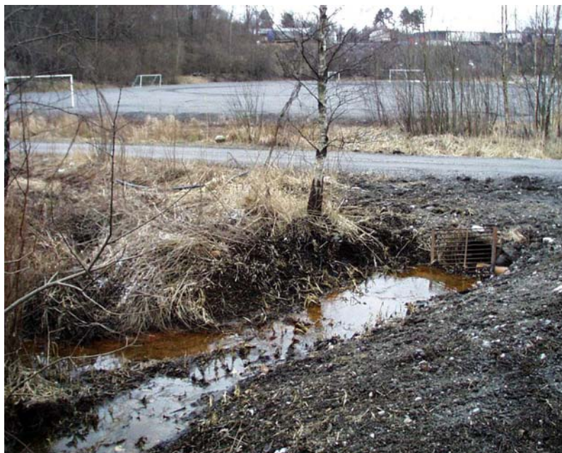
Figur 2. Sigevann fra deponiet der det føres inn på kulvert
